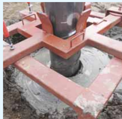
鋼管ぐいの挿入
