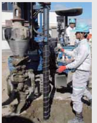
施工状況写真
