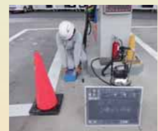
②土壌ガス試料採取状況
