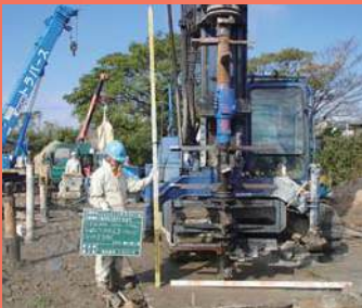
写真1-1 上部吐出弁ユニットを 装着例（φ1200）
