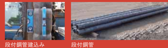
段付鋼管建込み
