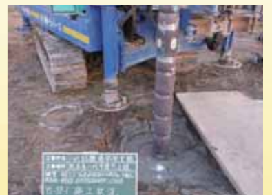
段付鋼管挿入
