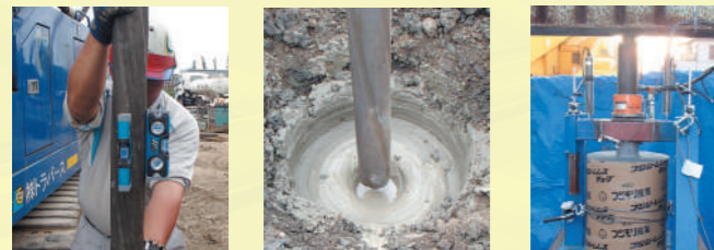
芯材建込み 芯材挿入 押し抜き試験
