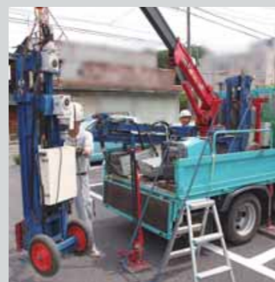
装置吊り下ろし
